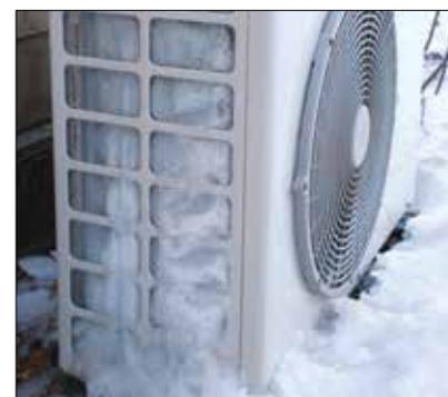
Cette photo montre un appareil inadapté au climat dans lequel il a été installé. Sans la technologie appropriée, le condensat gèle à l'intérieur de l'appareil, réduisant du coup son efficacité et sa puissance de chauffage.
